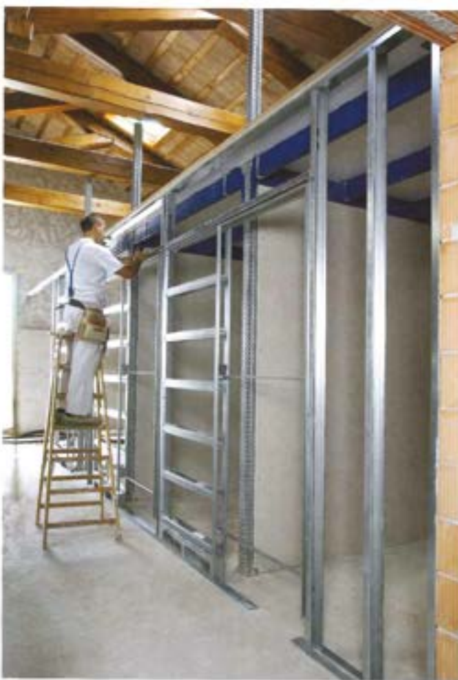
Struttura portante in metallo su cui andranno fissati i pannelli in cartongesso
