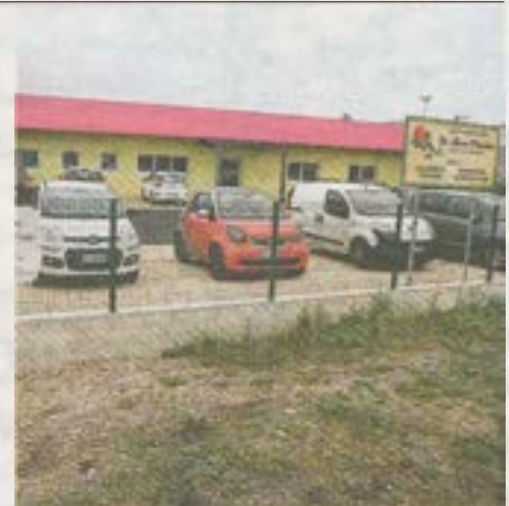
L'esterno della struttura in via Feltrina Sud
